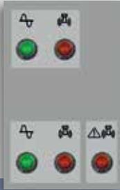
Abbildung zeigt das Leuchtmelder-Modul einer CPSM2.
