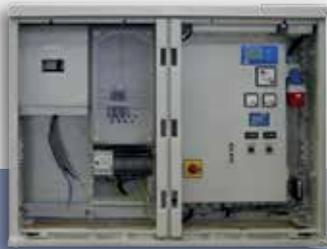
Modular aufgebaute Pumpensteuerung für bis zu 2 Pumpen mit einem Leistungsspektrum bis max. 75 kW je Pumpe:
