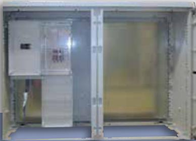
Verteilerschrank mit EVU-Leerplatz (links), Gesamtbreite ... mm aus Glasfaser verstärktem Polyester IP 44, getrennter Innenraum, EVU-Leerplatz mit Doppelschließung, Kundenteil mit Einfachschließung, werkseitig eingebautem Gleichschließzylinder Type 9001 inkl. Sockel, Kabelabfangschiene und Montageplatten.
