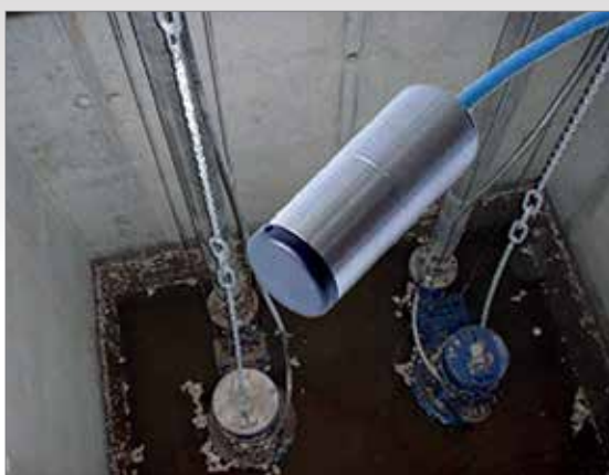
Niveausonde ENS überwacht z. B. Abwasser- / Wasserstand in einem Pumpenschacht
